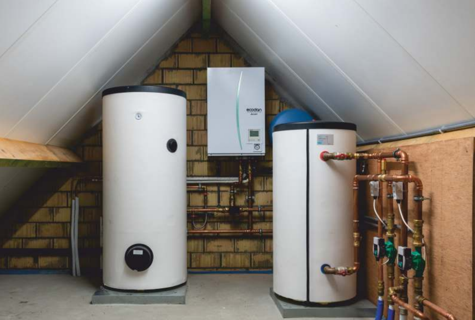
Zobrazenie inštalácie nástenného hydromodulu s externým zásobníkom TUV a akumulácnou nádobou
