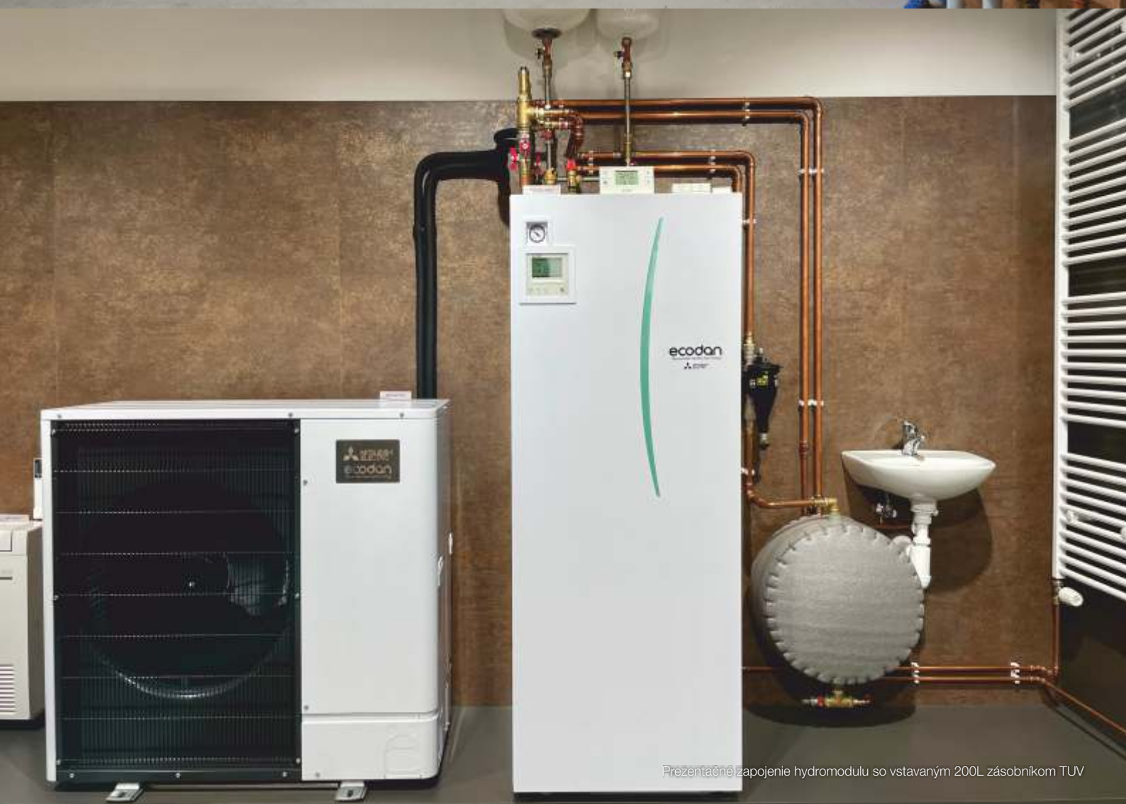
Zobrazenie inštalácie nástenného hydromodulu s externým zásobníkom TUV a akumulácnou nádobou
